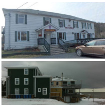
Figure 15 : Le motel Le Métropole de Saint-René-de-Matane (photo à gauche) ainsi que le Manoir des sapins (photo de droite) à Sainte-Félicité sont deux exemples de bâtiments rectangulaires à toit en pavillon (Source : GoNet)
