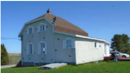
Figure 147: Un bel exemple de maison à toit en demi-croupe et sa cheminée centrale à Saint-Adelme (Source: GoNet)
