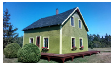
Figure 7: Un autre exemple de maison de colonisation à deux versants droits à Sainte-Félicité (Source : GoNet)
