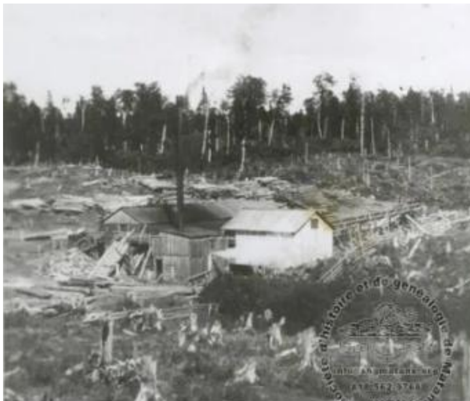
Figure 142: Scierie de Moïse Ross à Saint-Adelme (Source: SHGM)
