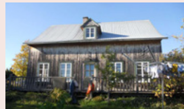
Figure 88: Un bel exemple de la maison québécoise à toit à deux versants recourbés à Baie-des-Sables (Source : GoNet)
