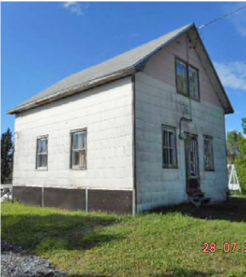
Figure 163: Un des derniers témoins bâtis du village de Saint-Nil sur le 12 e et 13 e rang (Source : GoNet)
