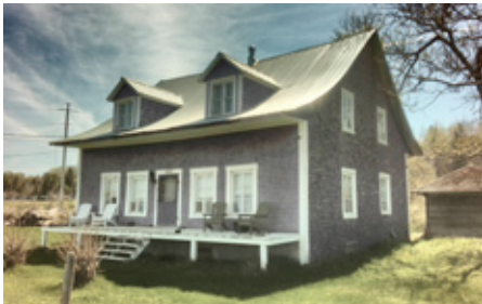
Figure 73 : Une maison québécoise à Saint-Ulric. Cette belle demeure ancestrale conserve plusieurs de ses composantes d'origine, dont son revêtement en bardeau de cèdre et ses fenêtres à battants à grands carreaux (Source : GoNet)
