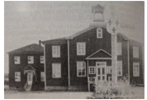
Figure 115: Le premier couvent construit en 1913 à Les Méchins par Eustache Verreault (Source: Dion, 1983, p. 457)
