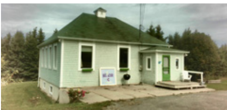
Figure 91: Une ancienne école de rang, aujourd'hui la bâtisse d'accueil du Motel Azur à Baie-des-Sables (Source : GoNet)
