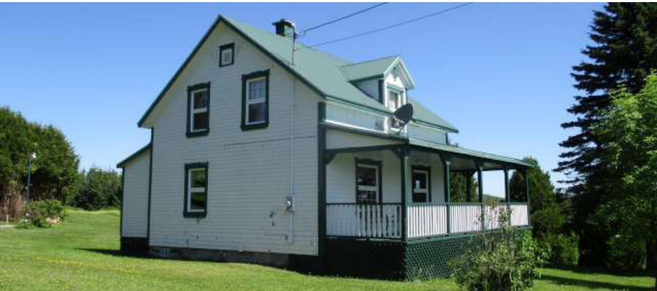
Figure 138 : Un autre exemple de construction de type colonisation avec sa lucarne à pignon en façade, sa galerie couverte et son garde-corps à barreaux à Sainte-Paule (Source : GoNet)
