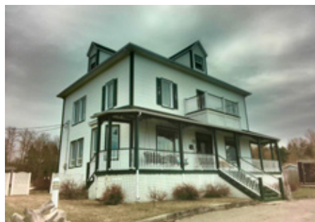
Figure 94: La maison du Dr Jean à Baie-des-Sables (Source: GoNet)
