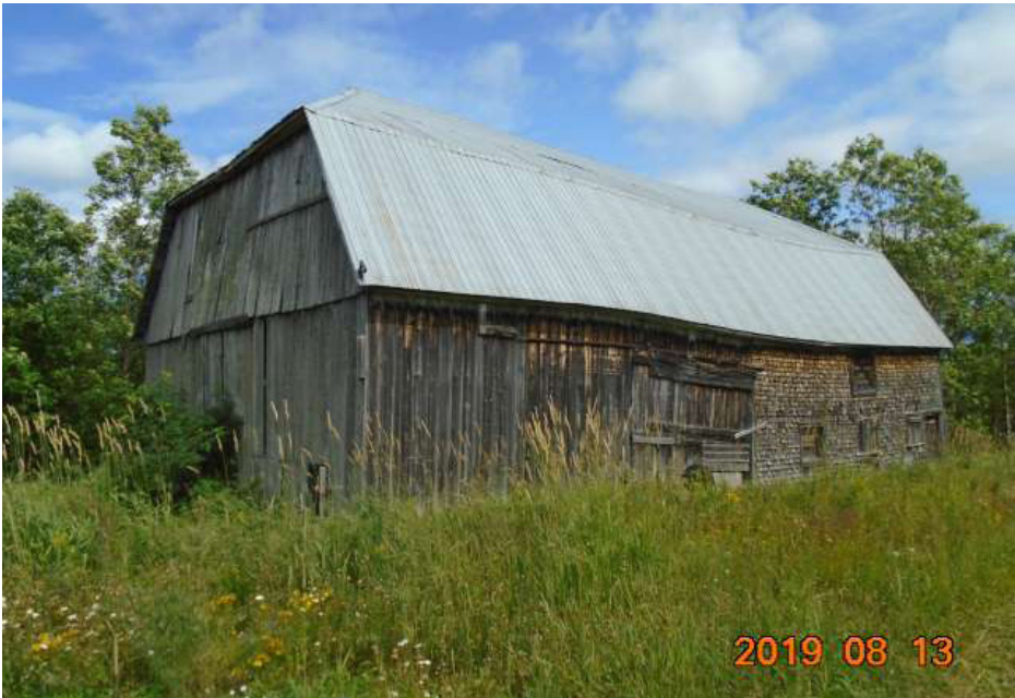
Figure 148: Un exemple de grange à toit en demi-croupe à Saint-Adelme, unique sur le territoire de la MRC (Source: GoNet)
