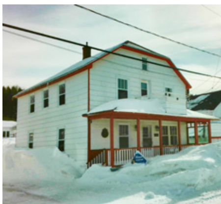
Figure 180 : Un exemple de maison à toit en demi-croupe à Grosses-Roches (Source : GoNet)
