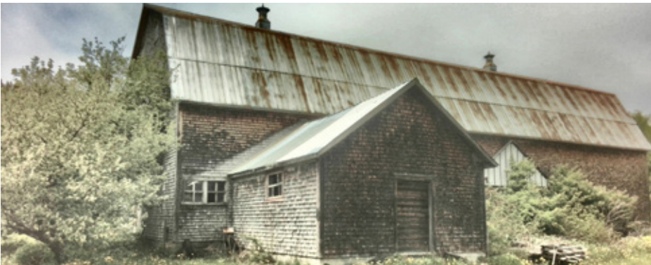
Figure 79 : Une grange-étable à toit brisé recouvert de tôle pincée. On distingue deux lanterneaux sur le toit et son parement en bardeau de cèdre (Source : GoNet)
