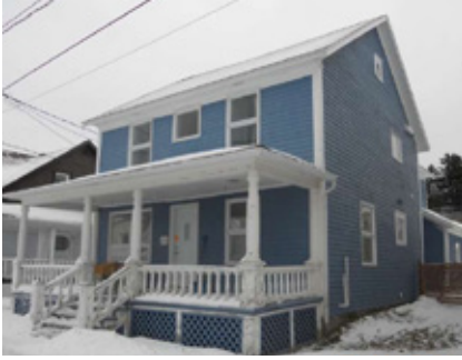
Figure 16: Modèle de vernaculaire industrielle située à Saint-Ulric (Source: GoNet)
