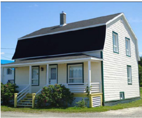
Figure 105 : Assez courante dans la municipalité de Sainte-Félicité, la maison à toit mansardé est populaire dans l’est du Québec à partir des années 1880. Sa toiture offre plus d’espace dans les combles que les maisons québécoises au toit à deux versants recourbés, d’où sa popularité. (Source : GoNet)
