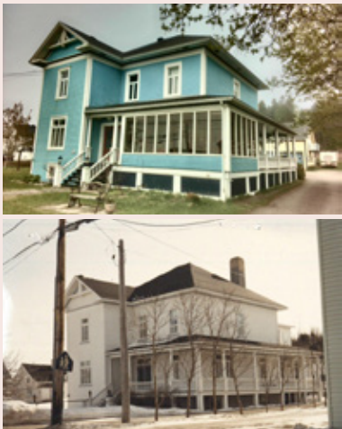
Figures 75-1 & 75-2 : Cette imposante demeure sur l'avenue Ulric-Tessier a accueilli pendant de nombreuses années une auberge. La photo de gauche illustre la propriété en 1988, tandis que celle de droite est le bâtiment en 2024. (Source : GoNet)
