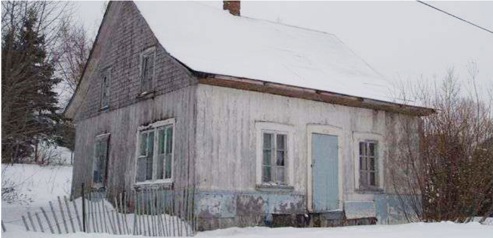
Figure 53: Charmante petite maison de colonisation à deux versants recourbés, construite en 1898, dans le secteur Saint-Luc-de-Matane (Source: GoNet)
