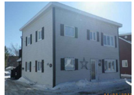
Figure 14 : Une maison cubique à toit plat à Matane (Source : GoNet)
