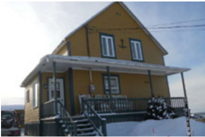
Figure 17: Un exemple de maison vernaculaire avec le mur pignon en façade à Baie-des-Sables (Source: GoNet)
