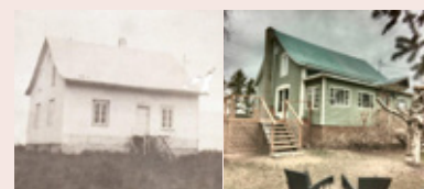
Figures 1-1 & 1-2 : Compréhension de l'évolution du bâti grâce aux archives photographiques d'un bâtiment à Baie-des-Sables (avant : photo à gauche et après : photo à droite) (Source : GoNet)
