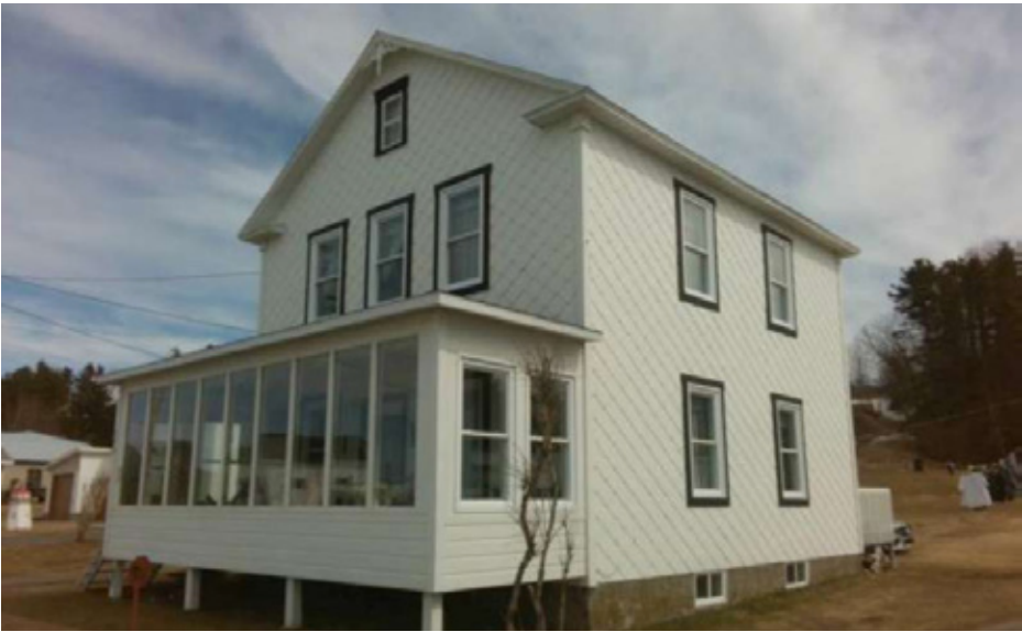
Figure 123 : Un très beau modèle de maison vernaculaire à étage à façade mur pignon à Les Méchins. On reconnaît le parement en bardeau d’amiante et le retour de corniche de la façade (Source : GoNet)
