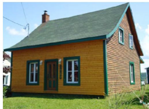
Figure 129: Un exemple de maison de colonisation à toit recourbé à Saint-Léandre (Source : GoNet)
