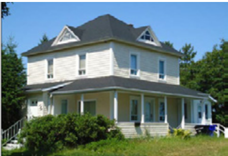
Figure 119 : Maison de type cubique construite en 1940. Cet exemple original possède plusieurs lucarnes en chatière avec des fenêtres aux motifs géométriques alors que le plus souvent ces maisons cubiques présentent des lucarnes à croupe. (Source : GoNet)
